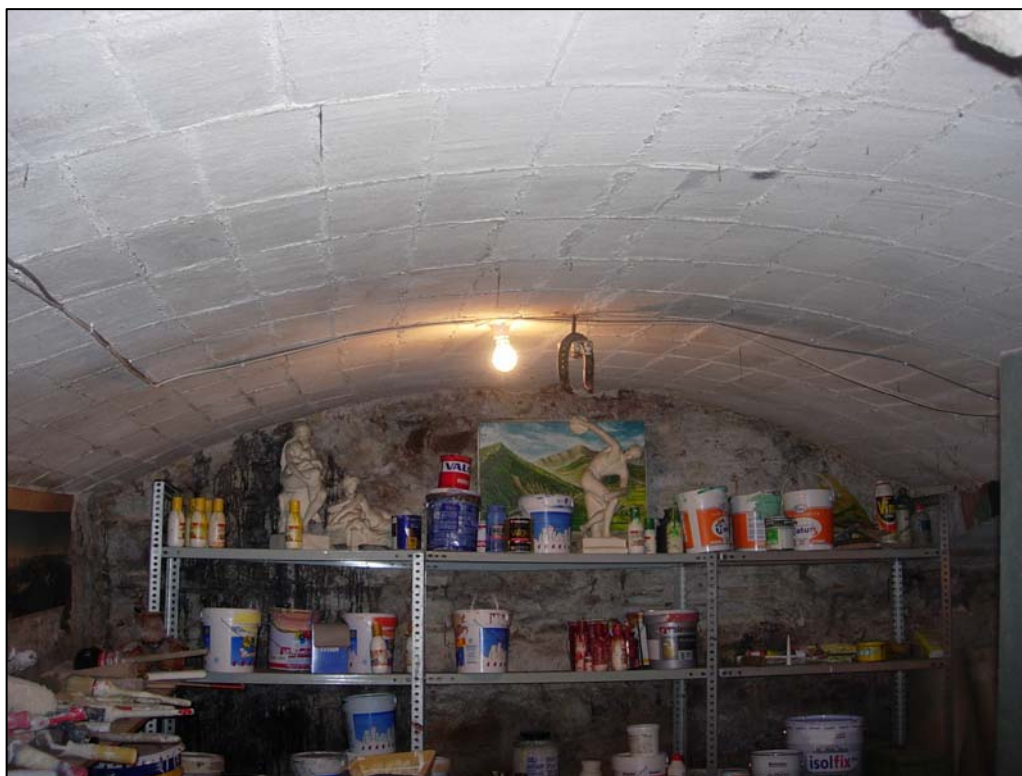
Foto 1: Detall de la volta (UE 06) vista des de l'interior del soterrani situat al carrer Mare de Déu del Pilar numero 15.
