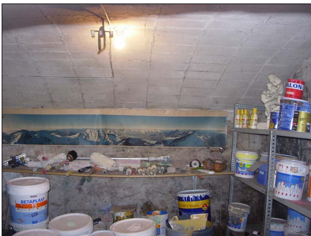
Foto 2: Detall de la volta (UE 06) vista des de l'interior del soterrani, just a la zona on s'ubicarà el fossat de l'ascensor.
