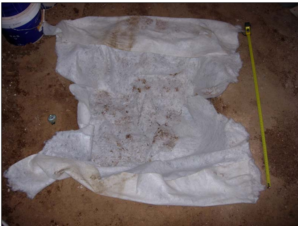
Foto 3: Procés de cobriment el sondeig 2 amb geotèxtil.
